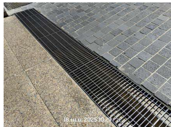
รูปที่ 2.38 ตะแกรงดักขยะ
